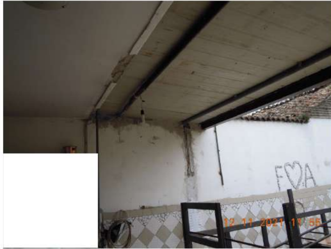
Particolare Tettoia Foto 16
