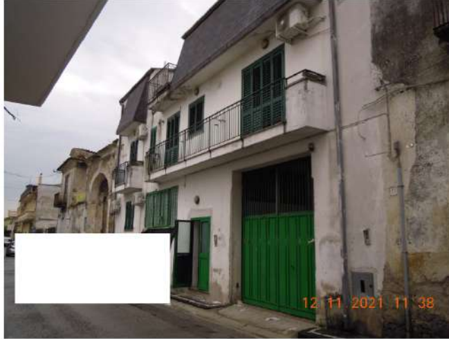
Vista da Via Chiesa Foto 1
