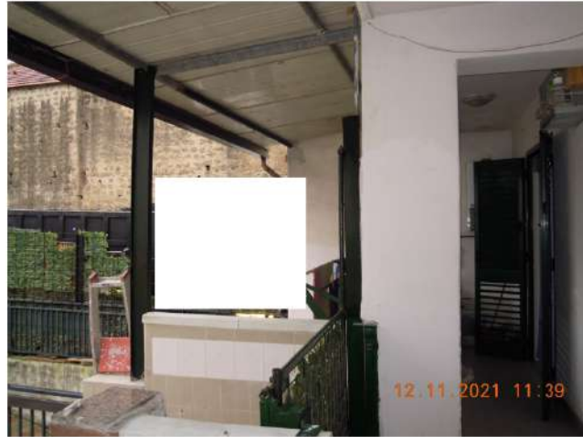
Veduta tettoia Foto 7
