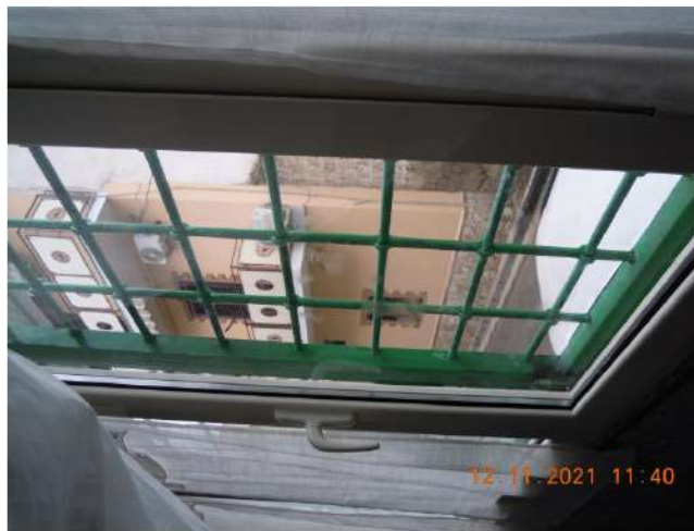
Particolare chiusura balcone Foto 11
